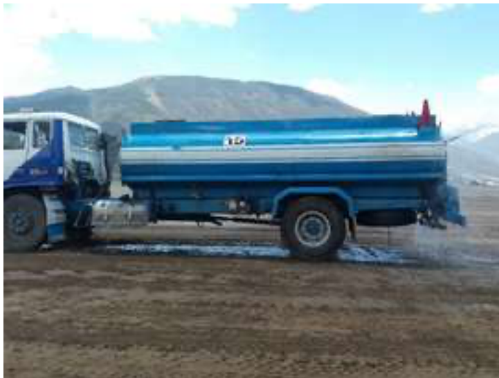
Figura: Tanquero regando agua para evitar levantamiento de polvo
