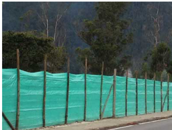
Figura: Cerramiento con yute con parantes de madera
